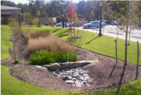
Jardin de pluie d'infiltration. Source W&M Rain Garden
